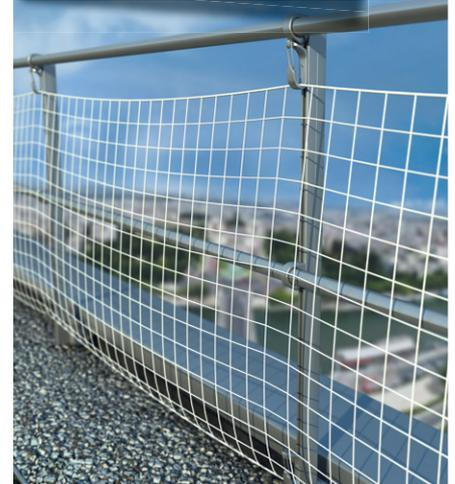
Accrofil ist ein Befestigungssystem für Schutznetze, das speziell für die permanenten Sicherheitsgeländer der Marke Barrial entwickelt wurde.
